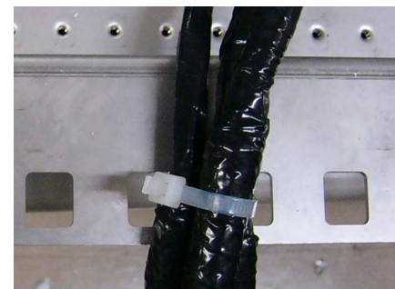
Fije los cables al poste con una brida.
