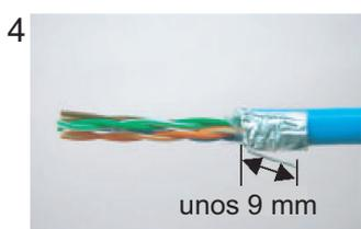
4 Doble hacia atrás el conductor de retorno y córtelo, dejando 9 mm.
